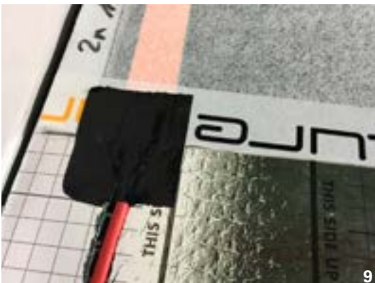
Abbildung 9: Kabel in die dafür vorgesehenen Schlitz in der Dämmung einlegen. Schlitz mit Alu-Band verschließen.
